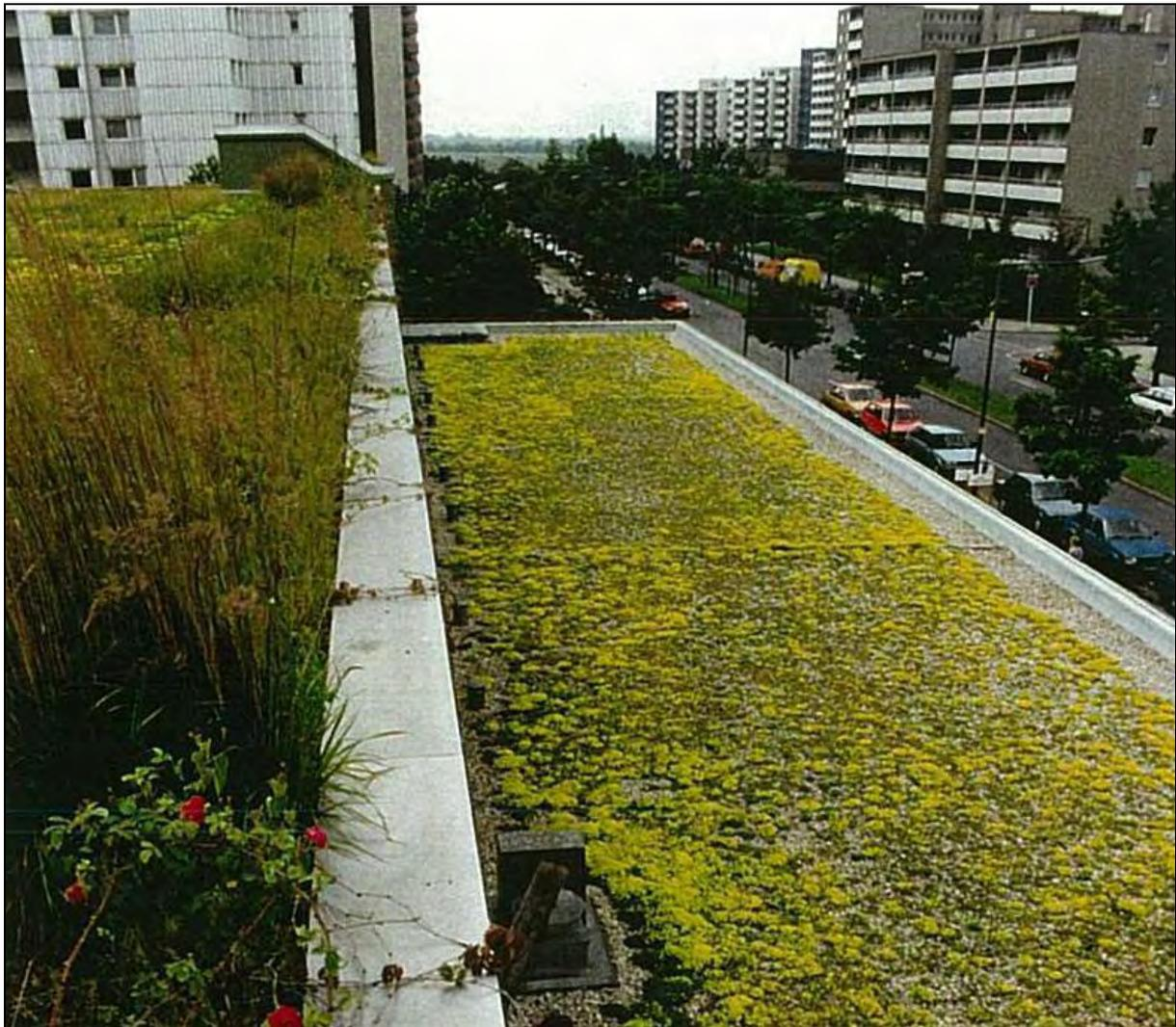
Pflegefreies Biotopdach auf dem Dach der Ladenzeile mit einer Aufbauhöhe von **1-2 cm** und ohne eine Wurzelschutzbahn, da diese aufgrund der verfügbaren Lastannahme zu schwer wäre. Bauherr und Planer waren einig, dass bei dieser Aufbauhöhe keine aggressive Wurzelbildung stattfinden kann.
