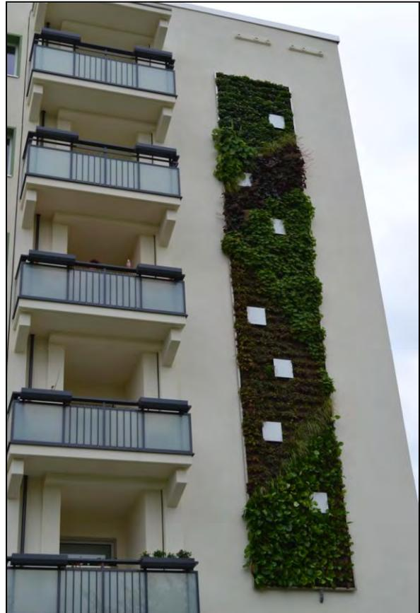
Intensiv-Fassadenbegrünung mit automatischer Bewässerung und Nährstoffversorgung
