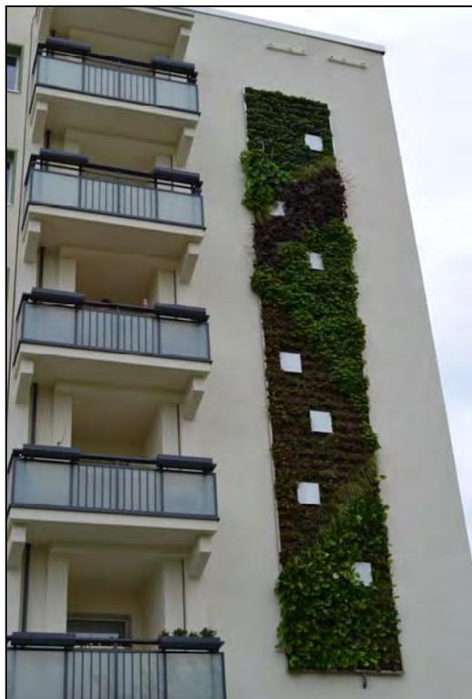
Intensiv-Fassadenbegrünung mit automatischer Bewässerung
